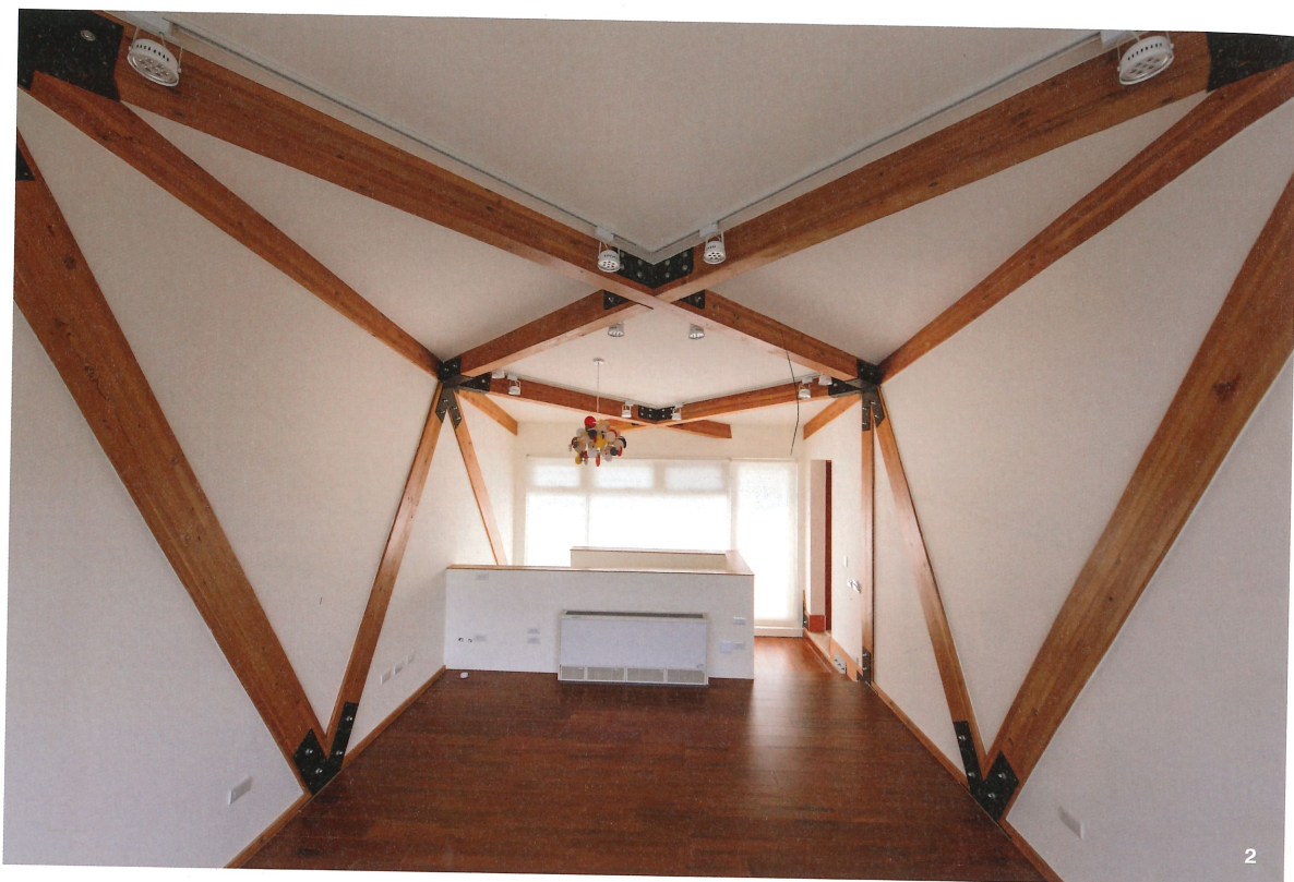
1 住宅正立面 2 膠合樑組構的頂樓
