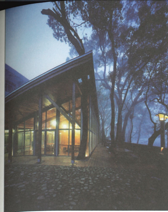
「鳳凰茶園」透過玻璃盒的表現手法，使木構造建築與周遭的百年樟樹林相容無間，並在不砍伐、移植原生樹林的前提下，任由樹木穿越雨遮，共構為建物一隅，重述建築、人與山林之間相存相依的親密關係。
