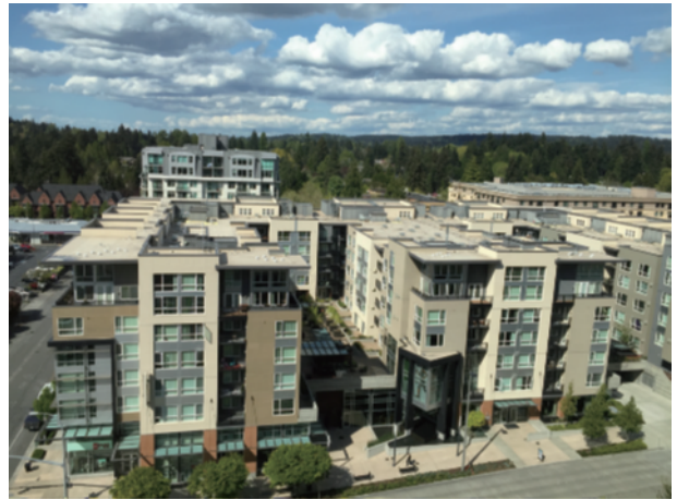
微軟總部所在的 Bellevue 市，市區中的高級公寓是 four over one（四層 2X4 式木構造蓋在一層 RC 構造上）的方式構築而成。
