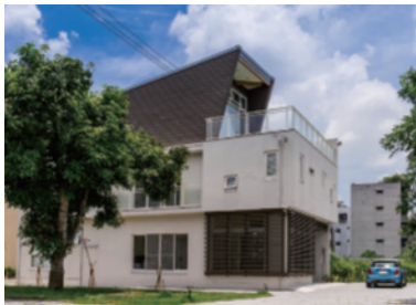
臺中潭子案，one over two 方式。第三層是木構造，戲劇性的視覺消點來自外露出 glulam（膠合樑）桁架系統，白色石膏板牆內則是 2X4 木骨料。這一層空間，成了此案全家不分老幼最喜歡駐留的生活點。
