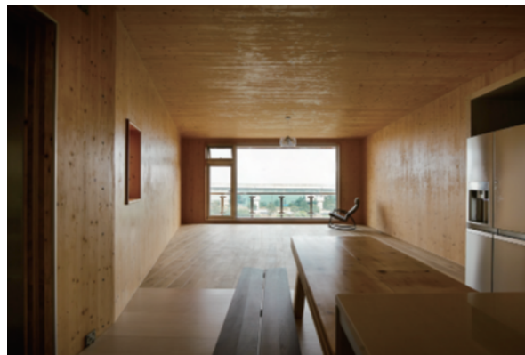
臺中WoodTek森科總部，利用CLT技術，從樓板、外牆都利用此新工法和材料構築。
