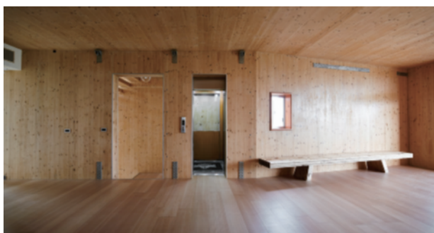
牆體已經具備承重功能，因此室內並無任何梁柱，讓外牆與結構合而為一，不須另外施作室內裝修。
