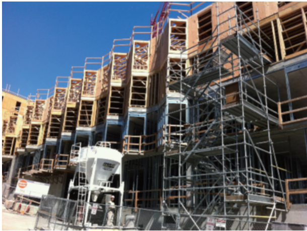
西雅圖的華盛頓大學學生宿舍，是 four over two（四層 2X4 式木構造蓋在兩層 RC 構造上）的方式構築而成。
