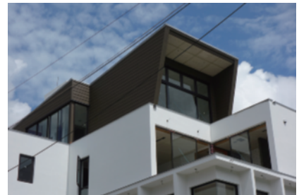
臺中南區案，one over three 方式。第四層是木構 S 造，以正統的 2X4 木骨料系統全面覆以具防火性的石膏板。
