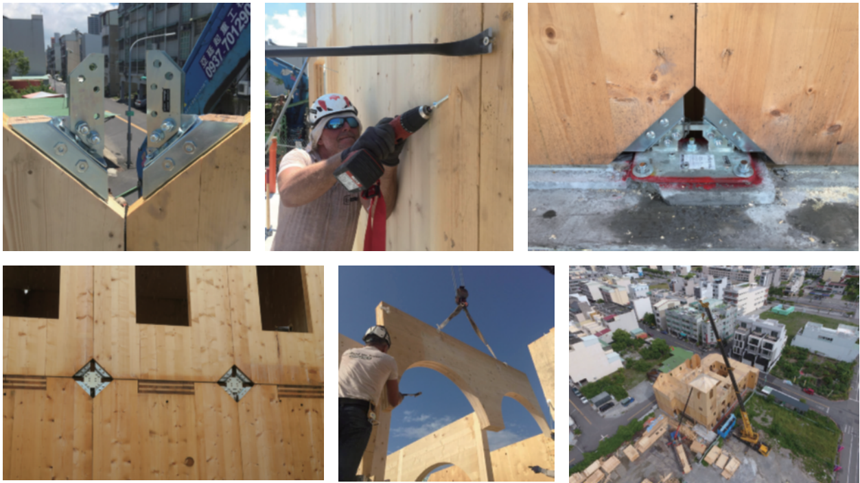
臺南安平案，每片板塊都預裁好後，運至工地吊裝，以義大利隱藏式五金作乾式組接，工法快速、精準，木構外殼施工期 28 天。 (圖片來源：Wood Tek)
