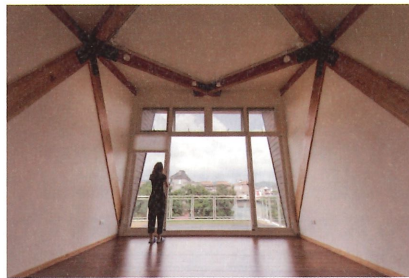
臺中潭子案，one over two 方式。第三層是木構造，戲劇性的視覺消點來自外露出 glulam（膠合樑）桁架系統，白色石膏板牆內則是 2X4 木骨料。這一層空間，成了此案全家不分老幼最喜歡駐留的生活點。
