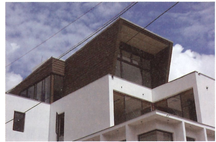
臺中南區案，one over three 方式。第四層是木構造，以正統的 2X4 木骨料系統全面覆以具防火性的石膏板。
