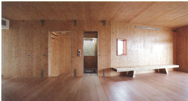
牆體已經具備承重功能，因此室內並無任何梁柱，讓外牆與結構合而為一，不須另外施作室內裝修。
